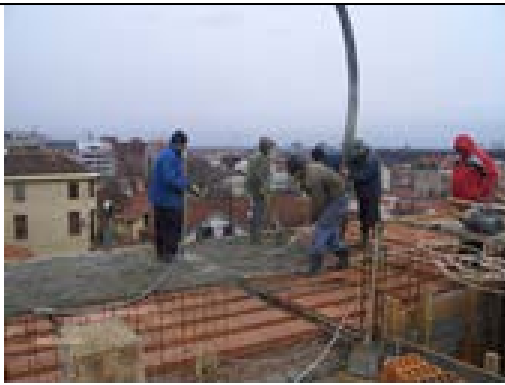
Сл.4.14.- Бетонирање плоче
